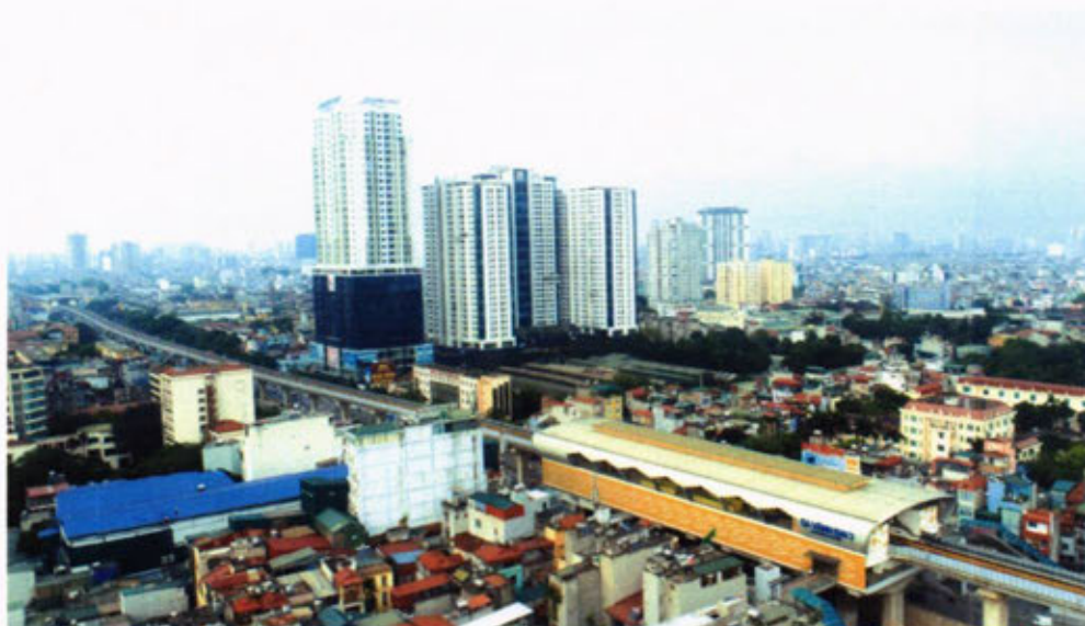
Toàn cảnh Gold Tower với lợi thế mặt tiền đường Nguyễn Trãi và ngay nút ga đường sắt trên cao
