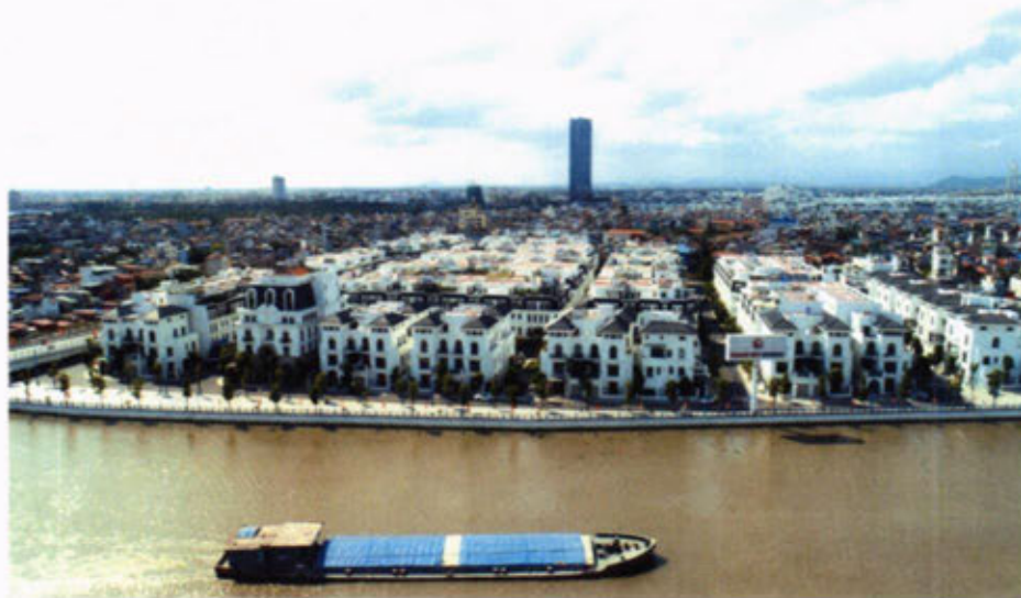
Dự án Hoàng Huy Riverside nhìn từ sông Tam Bạc
