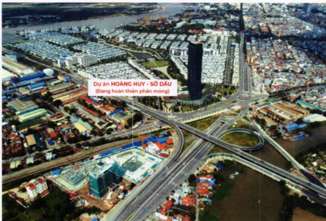
Hình ảnh tại công trường và tiến độ của dự án Hoàng Huy – Sở Dầu vào tháng 6/2021
