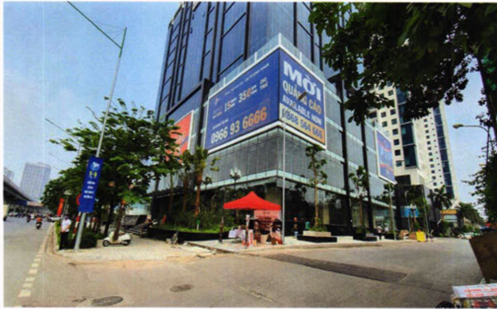
Mặt góc toà Gold Tower khi mới hoàn thiện
