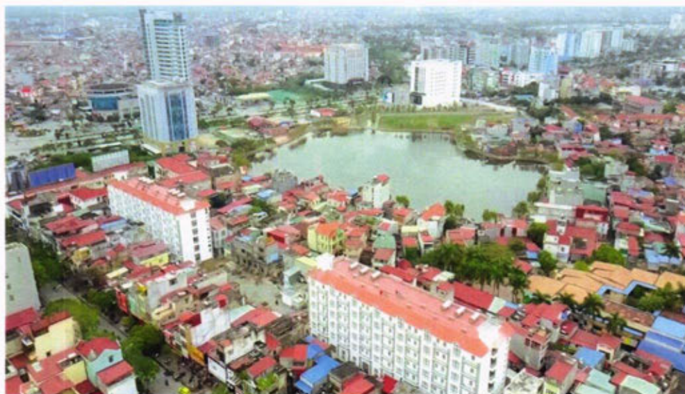
Hai toà nhà chung cư mới N1, N2 thay thế cụm chung cư cũ U1, U2, U3 Lê Lợi
