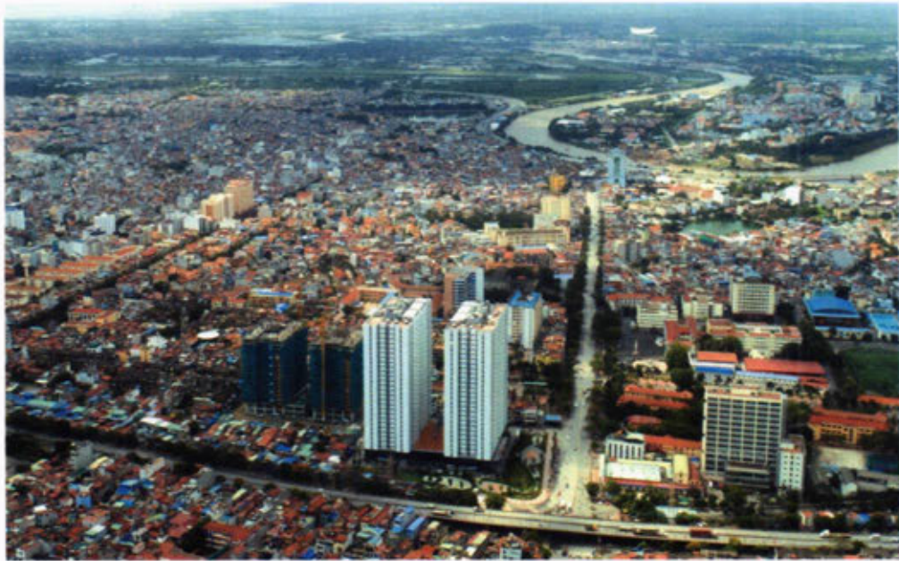
HH1, HH2 đang được thi công phần thân (nằm kề hai toà HH3, HH4 đã hoàn thiện)
