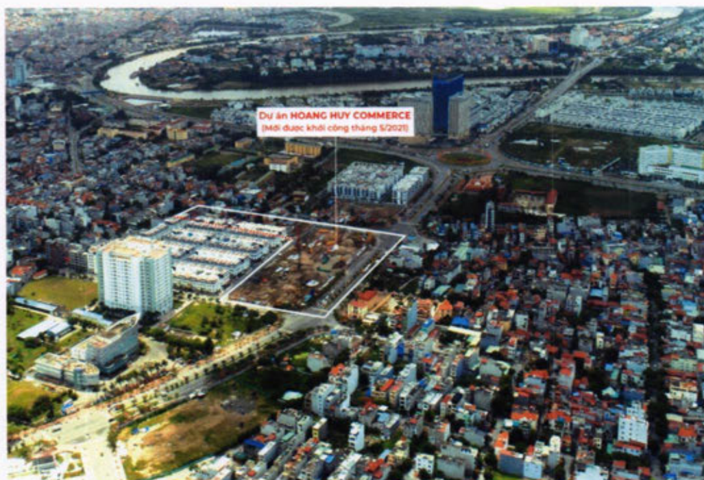
Hình ảnh công trường và tiến độ thực tế của dự án Hoang Huy Commerce vào tháng 6/2021
