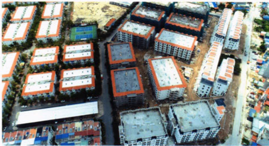
Các căn nhà chung cư và liền kề đang được khẩn trương thi công và hoàn thiện
